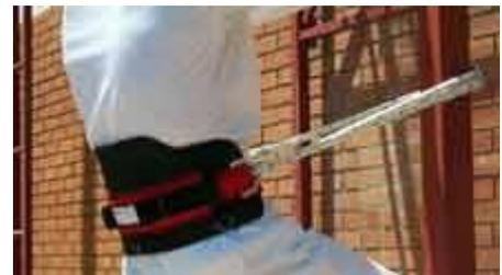
**Recuerda:** Para minimizar la caída libre, es importante, seleccionar un punto de anclaje estructural que se encuentre por encima del punto de conexión al arnés.
